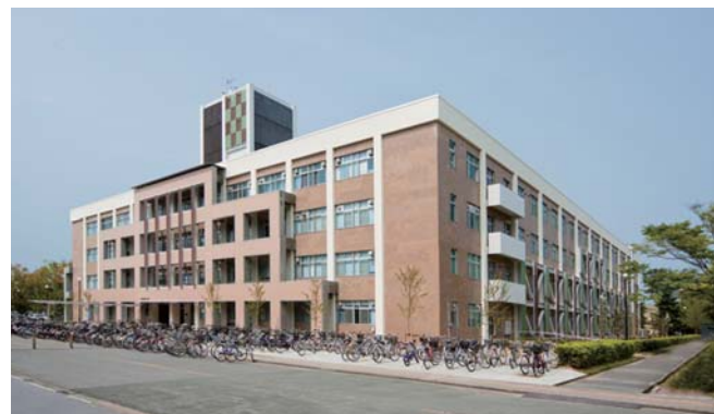
A 専門校舎1号館
