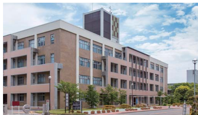
A 専門校舎1号館
